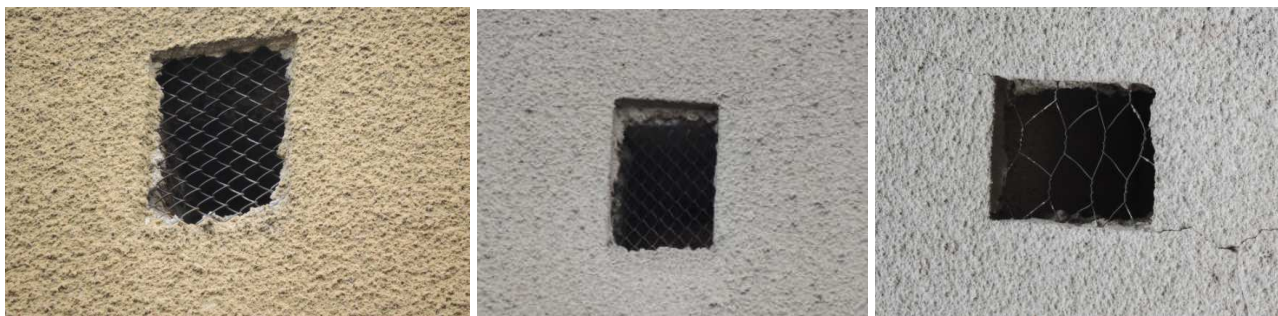
Foto 10-12. Otwory wentylacyjne zabezpieczone siatką.
