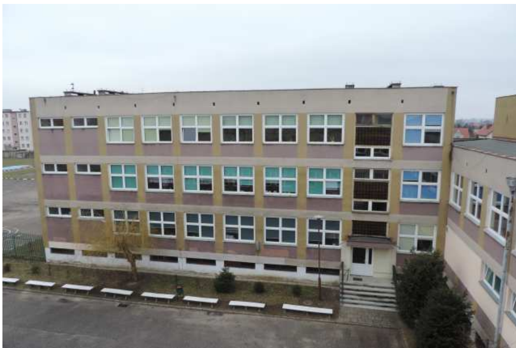
Foto 7. Budynek główny- elewacja wschodnia.
