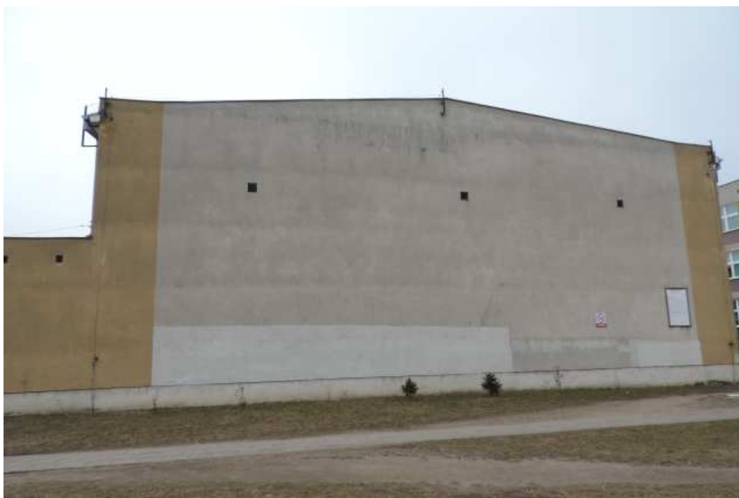
Foto 8. Południowa ściana sali gimnastycznej.
