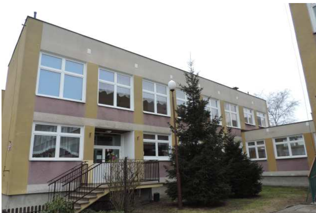
Foto 2. Gmach Przedszkola Publicznego nr 4, widok od strony wejścia głównego. Północna strona.
